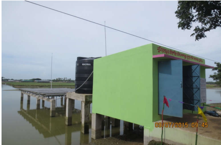
চিত্র- ৩৭ : সৌর শক্তিচালিত লবণমুক্ত সুপেয় পানি সরবরাহ প্লান্ট, নুনিয়ারছড়া, কক্সবাজার
