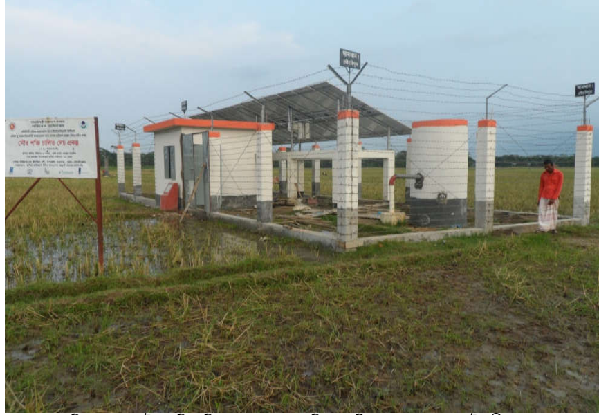
চিত্র- ৩৫ : সৌর শক্তিচালিত সেচ পাম্প, ছালিয়া কাজিরবন্দ, বড়লেখা, মৌলভীবাজার
